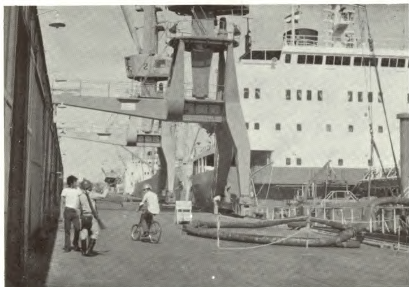
Fotografía 85: Puerto de Acajutla; muelle exterior. (Foto H. Lessmann).
