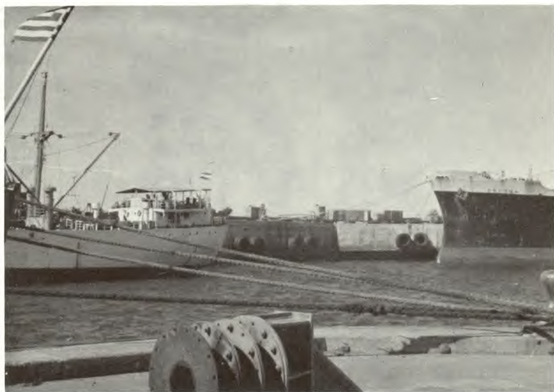
Fotografía 87: Puerto de Acajutla; visto hacia el rompeolas. (Foto H. Lessmann).
